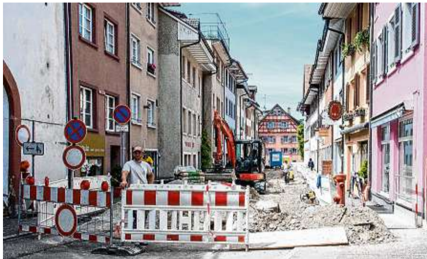
Der erste Bauabschnitt der Sanierung der Wallstraße ist in vollem Gange. Über die neuverlegten Wasserleitungen und Breitband-Leerrohre werden rote Porphyrtuff-Platten verlegt. Links im Bild: Jörg Kaiser von der Kaiser GmbH. BILD: PETER ROSA
